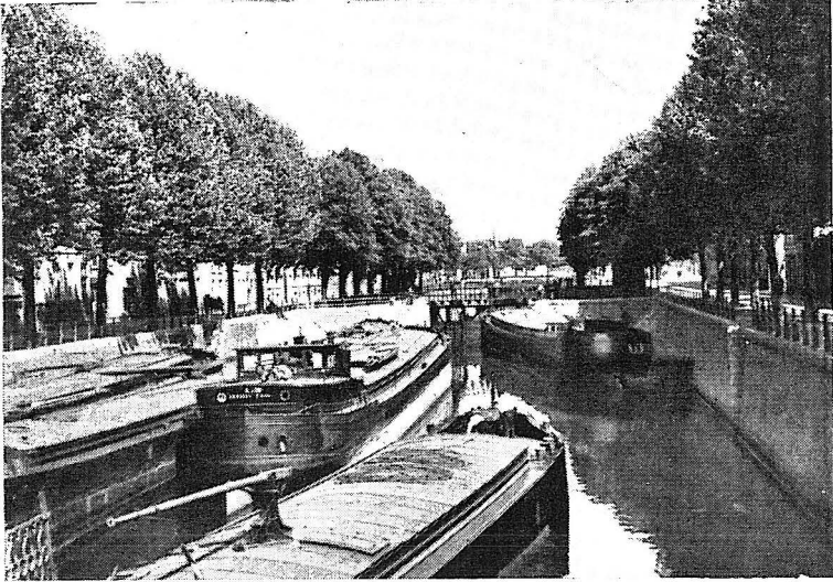
Kasteelsluis. Bovenwachtplaats. Ecluse du Château. Bassin d'attente amont.
